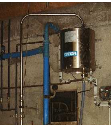
Pré-refroidisseur du lait pour les économies d'électricité et capteurs photovoltaïques raccordés au réseau pour la production...
